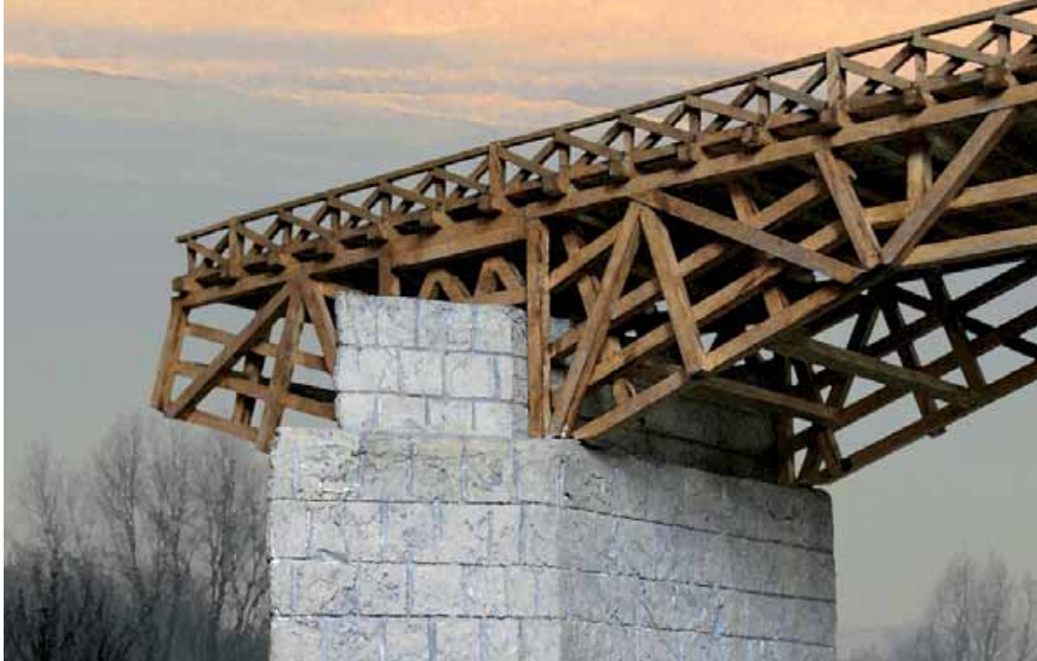
De Romeinse brug had stenen pijlers, waartussen houten liggers waren geconstrueerd.
