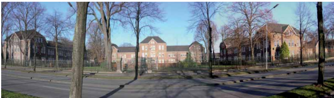
Aan de Prins Bisschopsingel liggen de Logiesgebouwen van de Tapijnkazerne, die sinds 2011 niet meer bij Defensie in gebruik zijn
