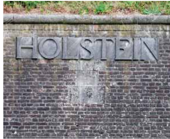
De grotere vestingwerken zoals bastions, ravelijnen en redoutes hadden namen en vaak werden die op een van de flanken in een hardstenen naamsteen gebeiteld
